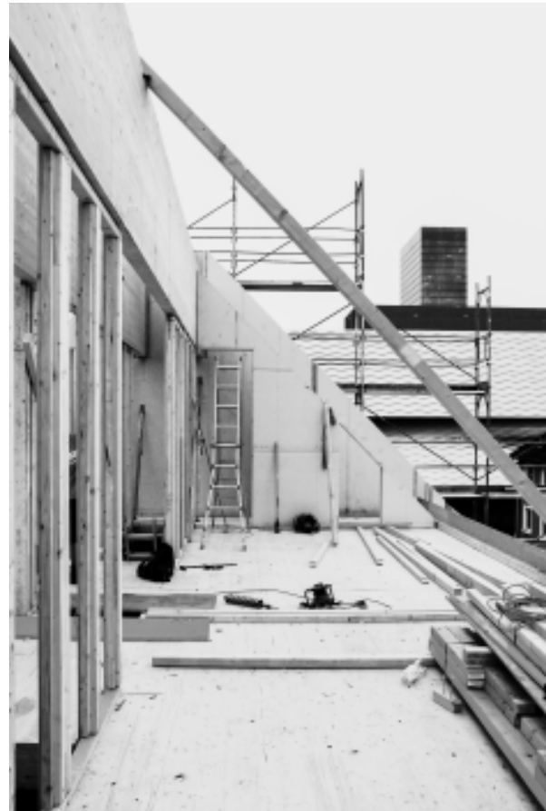
Baustellenfoto: Klar erkennbar sind die beiden tragenden Firstpfetten.
